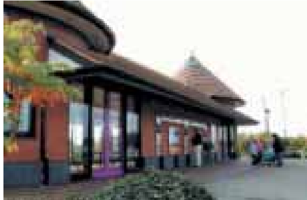
Wrexham Road P&R site
